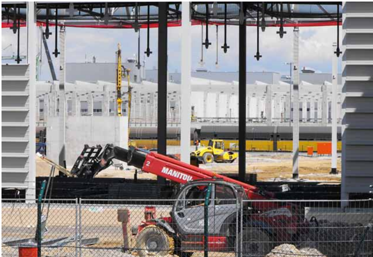
Die BMW-Westerweiterung ist derzeit Ostbayerns größte Baustelle
